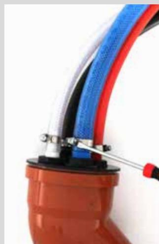
Die vom Schaltschrank kommenden Schläuche wie in Schritt ① und ② an die Tüllen anschließen und mit den Schlauchschellen abdichten.
