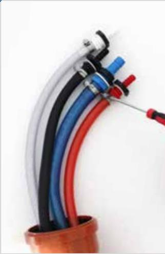
Schlauchschellen um die Tüllen festschrauben.
