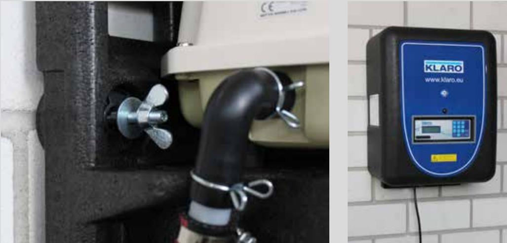
Den EPP-Schrank mit Hilfe der Unterlegscheiben und Flügelmuttern an den Stockschrauben befestigen.
