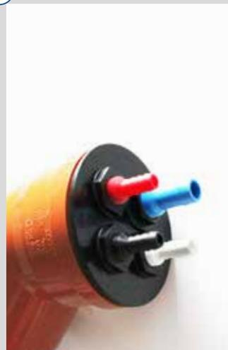
Deckel mit Gleitmittel bis zum Anschlag in die Muffe des Leerrohres schieben.
