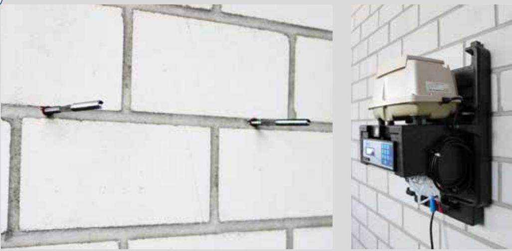
Die beiden Stockschrauben festschrauben und den EPP-Schrank (ohne Haube) aufhängen.
