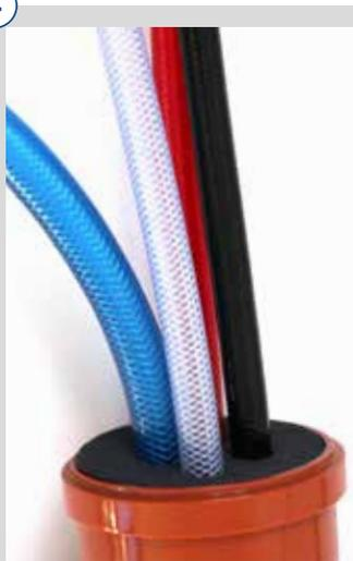
Deckel in die Leerrohrmuffe schieben, so dass dieses fest verschlossen ist.
